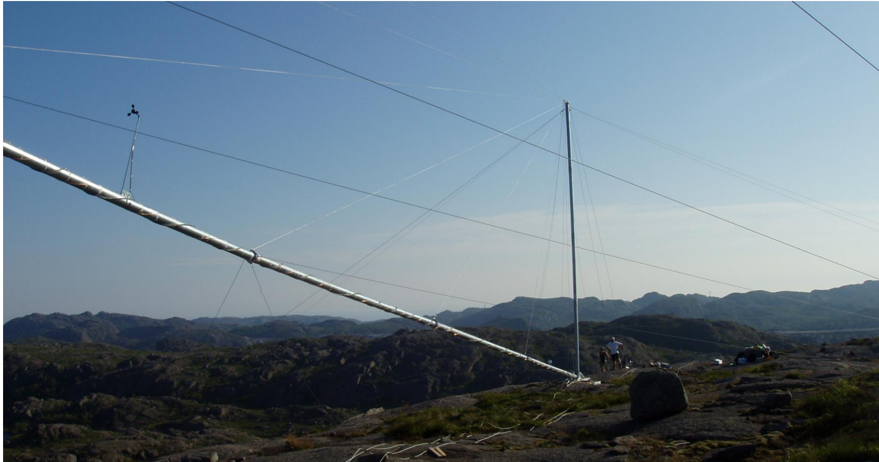
Figur 11: Reising av vindmålemast på Helleheia.
